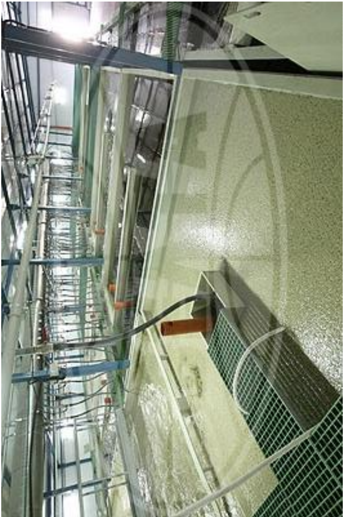
Многоступенчатая очистка воды. Сепараторы твердых отходов и биофильтры.
